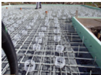
Abb. 2: Glasfasergitter vor dem Betonieren
