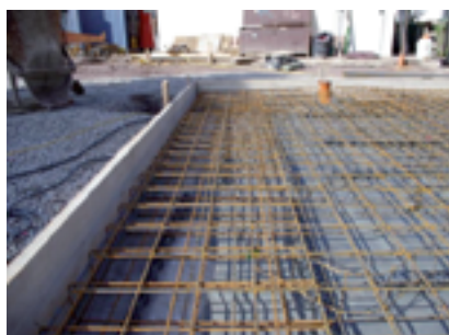
Abb. 1: Baustahlgitter vor dem Betonieren
